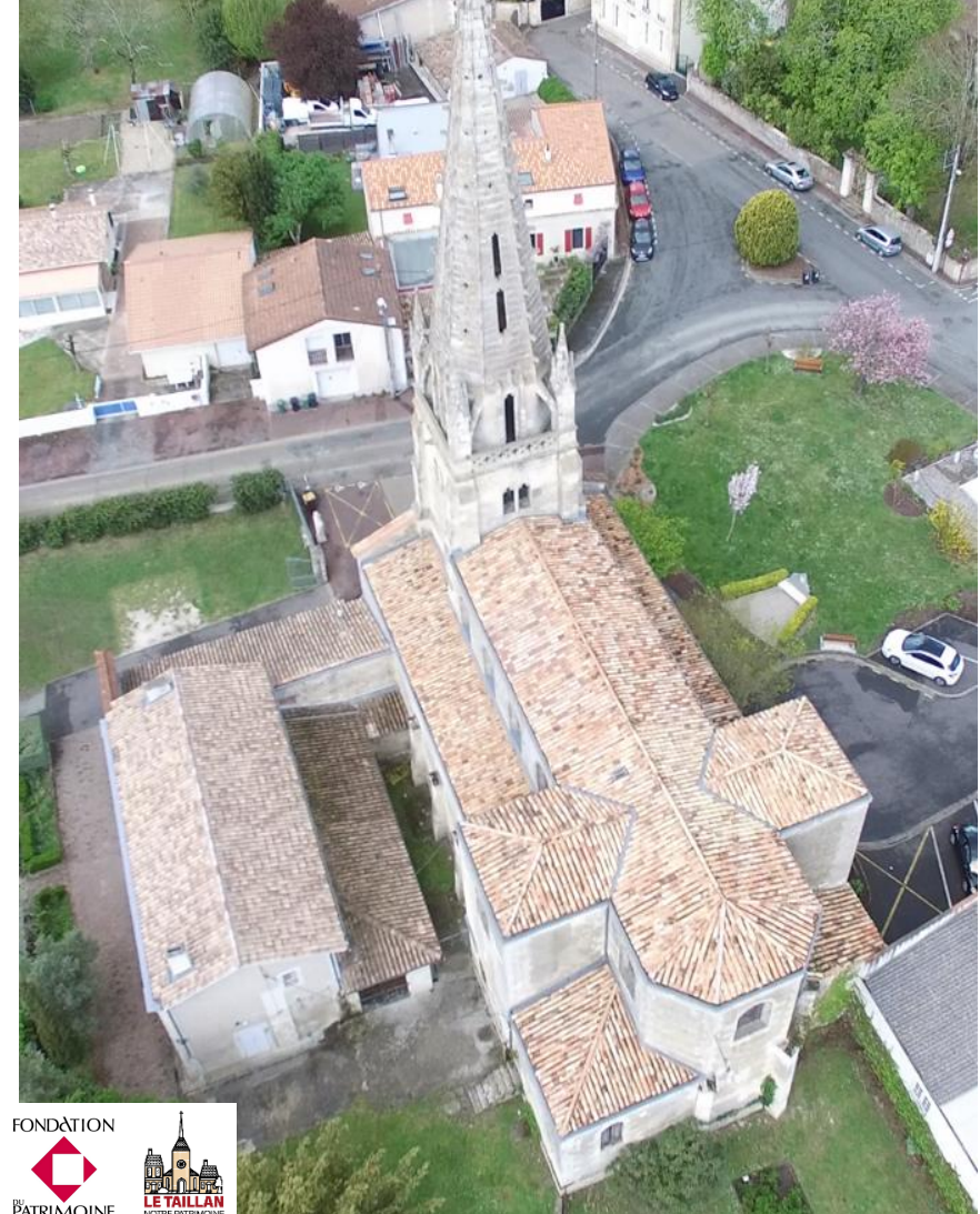
Rénovation de l'Eglise Fin des travaux janv. 2020
