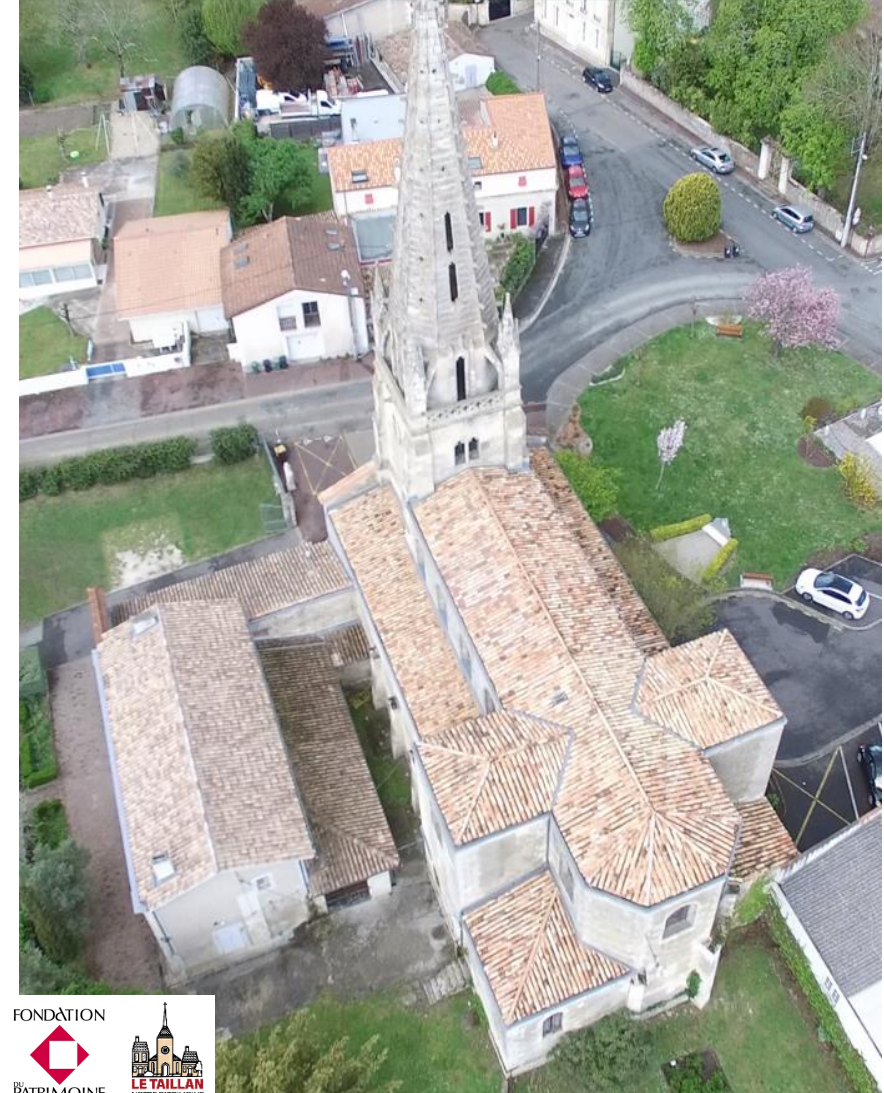
Rénovation de l'Eglise Fin des travaux janv. 2020
