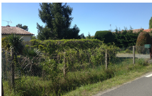
Grillage à maille torsadée fixé sur poteaux bois et agrémenté de plantes grimpantes
