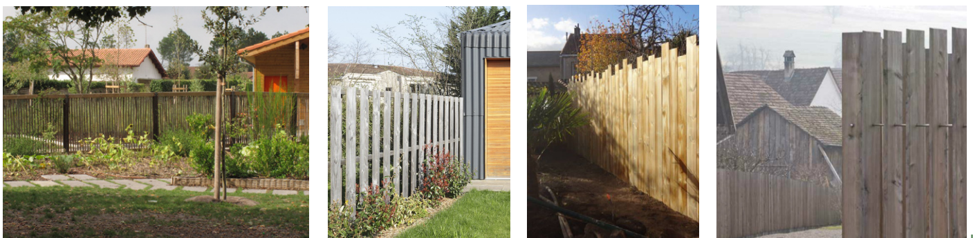
Poteaux métalliques à section carrée, lice bois et ganivelles châtaigner en habillage
