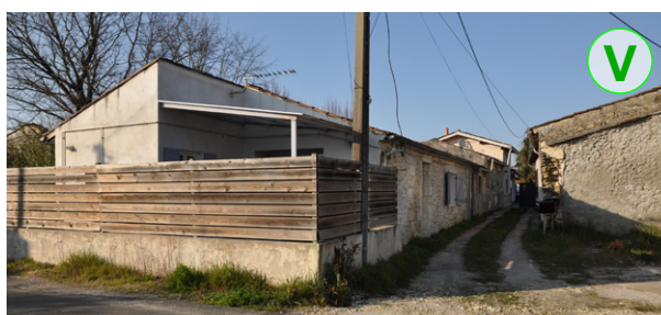
Voie d'accès privée en mélange terre-pierre, perméable
