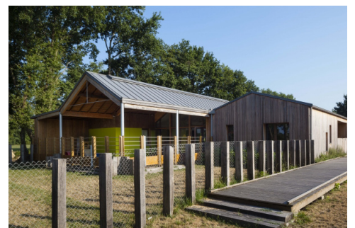
Poteaux bois brut section carrée et grillage à maille lonsange
