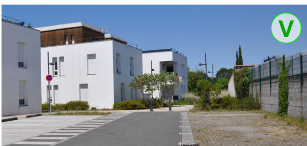
Aires de stationnement en dalles alvéolaires enherbées
