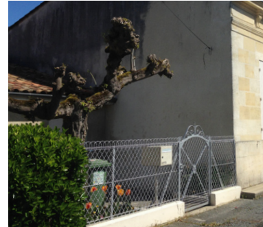
Muret bas surélévé par un grillage doublé d'une haie végétale
