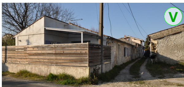
Voie d'accès privée en mélange terre-pierre, perméable
