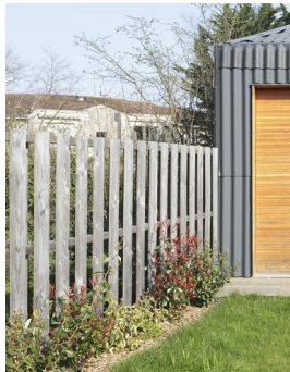
Palissade bois brut ajourée, contreplantée d'une haie
