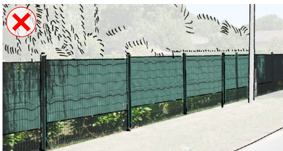
Clôture grillagée + géotextile vert peu esthétique
