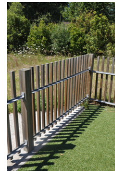
Palissade bois avec assemblages métalliques
