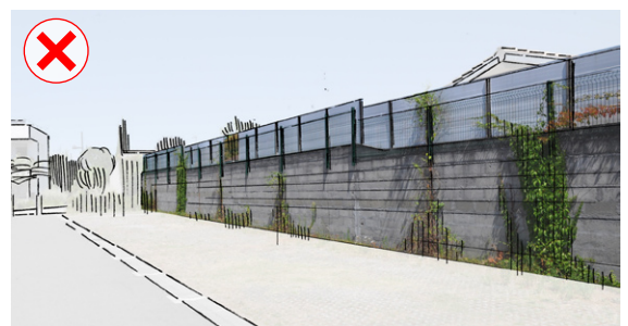
Matériaux à la finition brute non traitée peu esthétiques et vieillissants mal (parpaings non enduits et clôture plastique vert décolorée).
