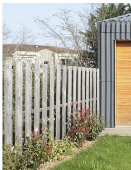
Palissade bois brut ajourée, contreplantée d'une haie
