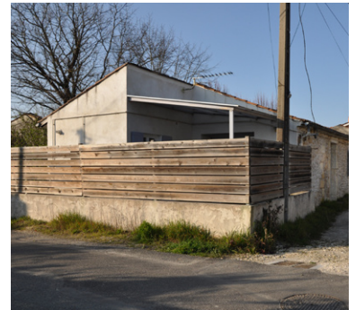
Mur bahut surélevé d'une palissade en bois à claire voie
