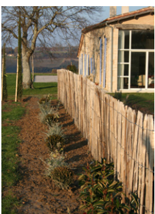
Différents types de clôtures en châtaigner de type ganivelle (ou clôture de Gironde). Une clôture très économique pour laquelle des hauteurs variées existent
