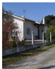
Mur pierre calcaire traditionnel enduit de chaux
