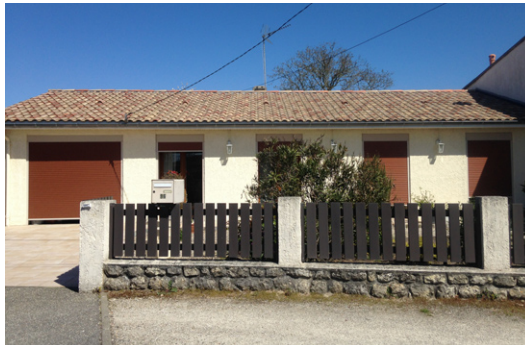
Muret bas en pierre surélevé d'un dispositif à claire voie en bois
