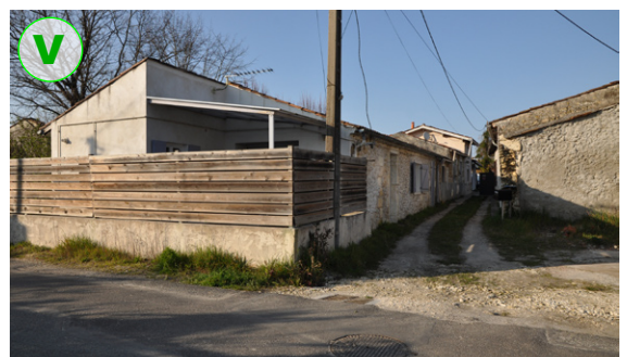
Muret bas + palissade en bois
