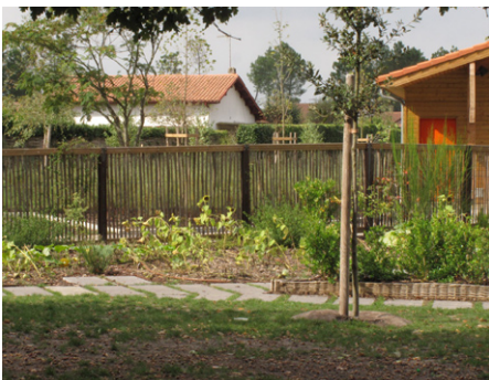
Poteaux métalliques sections carrée, lisse bois et ganivelles châtaigner en habillage
