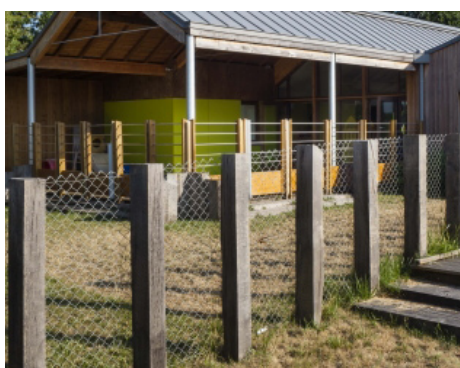
Poteaux bois brut section carrée et grillage à maille losange
