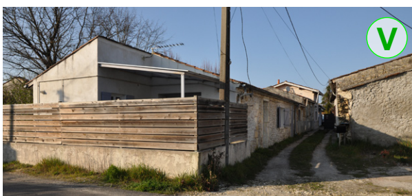
Voie d'accès privée en mélange terre-pierre, perméable
