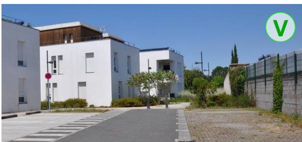
Aires de stationnement en dalles alvéolaires enherbées
