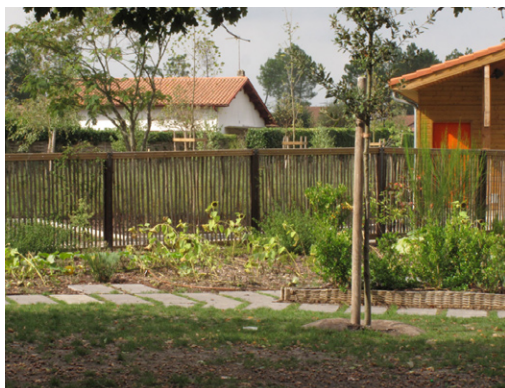
Poteaux métalliques sections carrée, lice bois et ganivelles châtaigner en habillage
