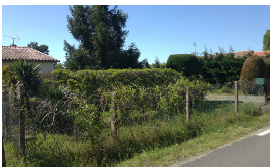
Grillage à maille torsadée fixé sur poteaux bois et agrémenté de plantes grimpantes
