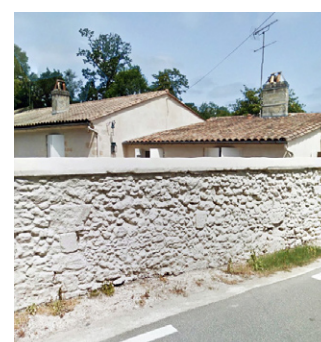
Mur pierre calcaire traditionnel enduit de chaux
