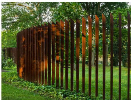
Lames d'acier corten inclinée pour fermer / et laisser passer les vues selon certaines orientations
