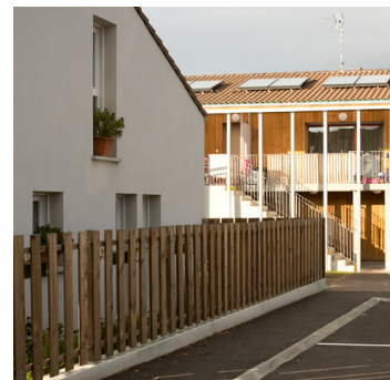
Palissade bois à claire-voie sur muret bas maçonné et enduit
