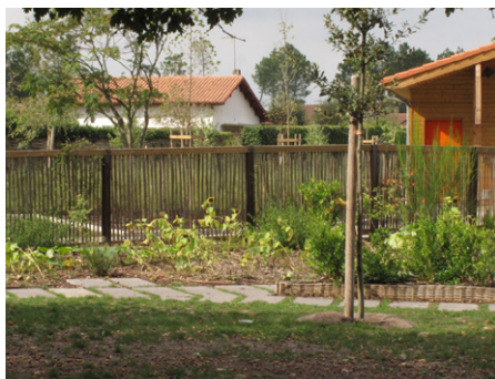
Poteaux métalliques de section carrée, lice bois et ganivelles châtaigner en habillage
