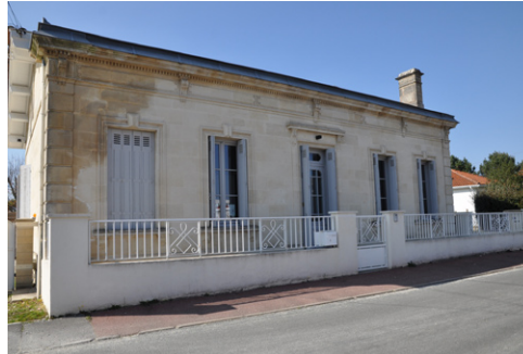
Murets bas + grilles fer forgé blanches, caractéristique de l'habitat ancien de type longère offrant une transparence avec la rue
