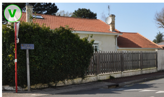
Clôture mur bahut + palissades bois + haies, caractéristiques des lotissements, plutôt qualitatives grâce à la présence du végétal et à une certaine harmonie au niveau de la rue, cependant il est préférable de privilégier des essences variées pour le traitement de la haie
