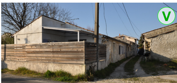
Voie d'accès privée en mélange terre-pierre, perméable
