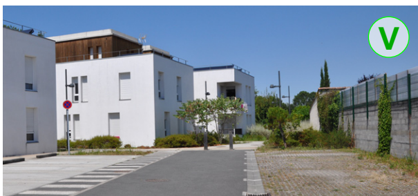
Aires de stationnement en dalles alvéolaires enherbées
