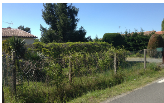
Grillage à maille torsadée fixé sur poteaux bois et agrémenté de plantes grim pantes
