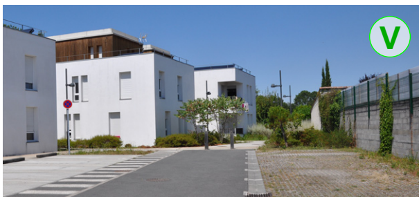
Aires de stationnement en dalles alvéolaires enherbées
