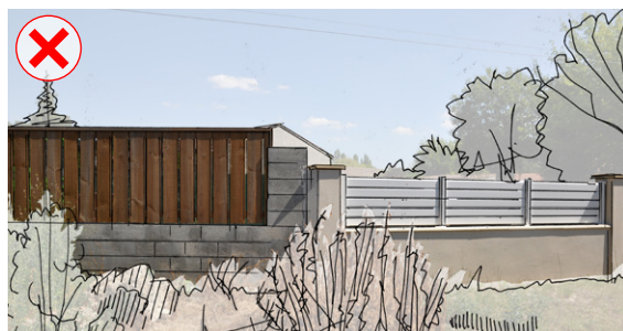
Une juxtaposition de deux clôtures de types et hauteurs variées, elles mêmes composées d'un assemblage de matériaux hétérogènes + mur en parpaings bruts
