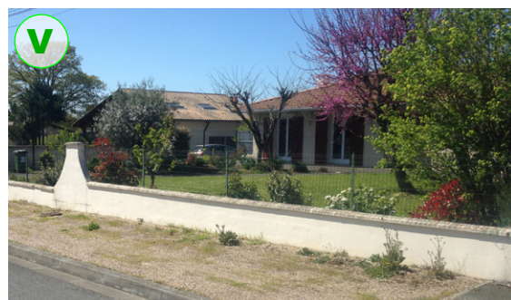
Muret bas + grillage + haie mixte caractéristique de l'habitat ancien de type longère, qualitatif du fait de sa transparence et de la présence du végétal
