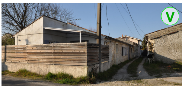
Voie d'accès privée en mélange terre-pierre, perméable
