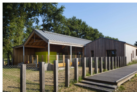
Poteaux bois brut section carrée et grillage à maille lonsange
