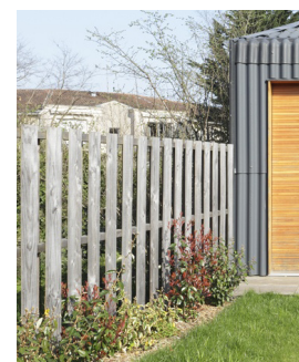
Palissade bois brut ajourée, contreplantée d'une haie
