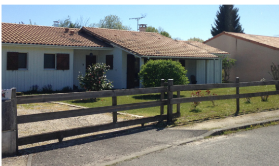
Clôture de type barrière pour chevaux, en planches de bois, créant une grande perméabilité entre l'espace public et l'espace privé
