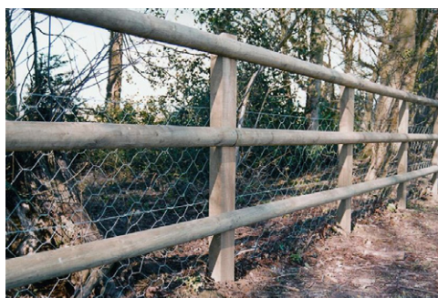
Clôture de type barrière pour chevaux, en rondins de bois doublée d'un grillage en partie basse
