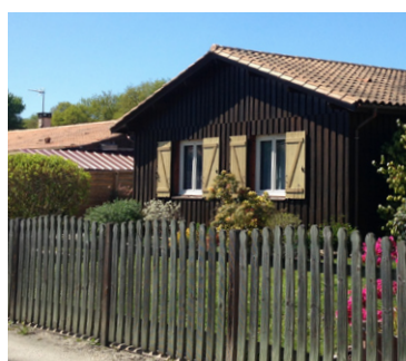
Palissade bois toute hauteur à claire voie
