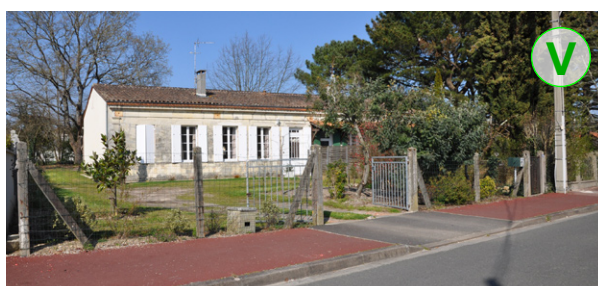
Cour intérieure et voie d'accès pour véhicule perméable
