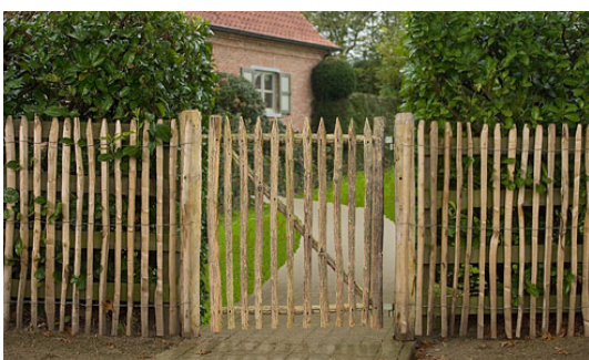
Ganivelle (ou Clôture de Gironde) formée de piquets de châtaigner assemblés
