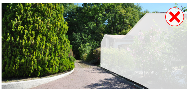
Les pavés autobloquants n'ont pas besoin de liant, ils restent cependant assez peu perméables
