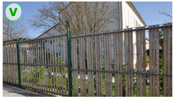
Clôtures préfabriquées treillis soudés habillées de lames de bois : une transparence intéressante
