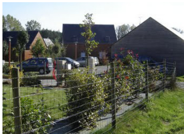
Poteaux bois section ronde + clôture de type ursus contreplantée d'une haie et bordée d'autre part d'un fossé
