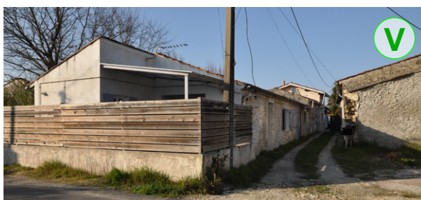
Voie d'accès privée en mélange terre-pierre, perméable
