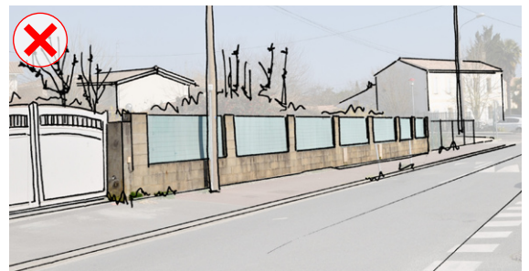
Matériaux à la finition brute non traitée peu esthétiques et vieillissants mal (parpaings non enduits et clôture plastique verte décolorée).
