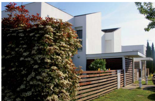
L'opération de Sandillan (habitat groupé) : lices bois horizontales toute hauteur
